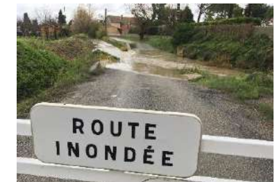
Sécurisation passage à gué
