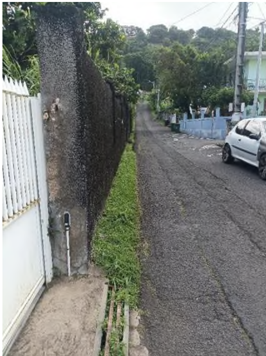
Figure 28 : Caniveau obstrué
