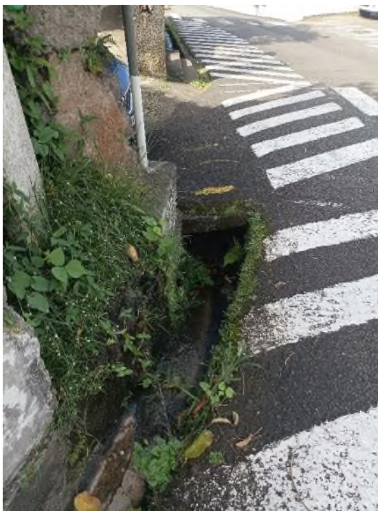
Figure 29 : Busage entre deux caniveaux
