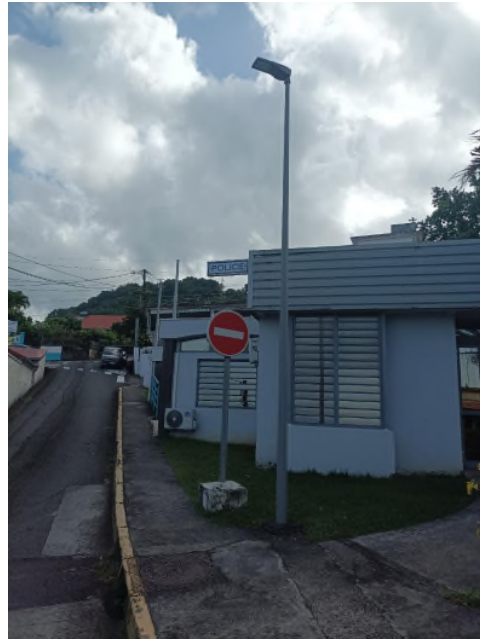
Figure 30 : Candélabre existant (proximité poste de Police)
