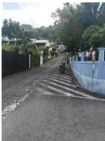
Figure 20 : Signalisation horizontale peu visible (partie haute de la rue Foccart)
