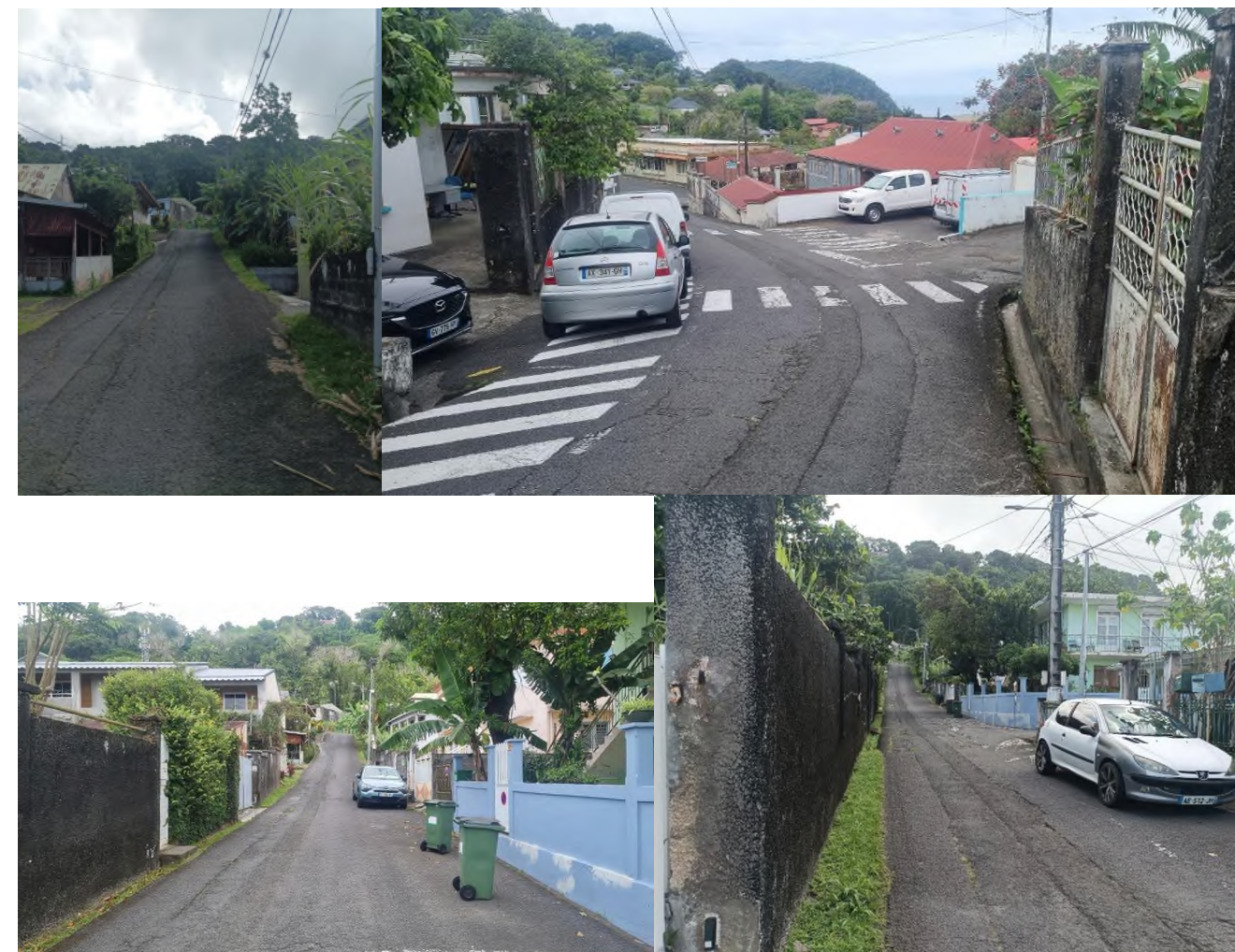
Figure 15 : Photographies de la rue Foccart sans trottoir
