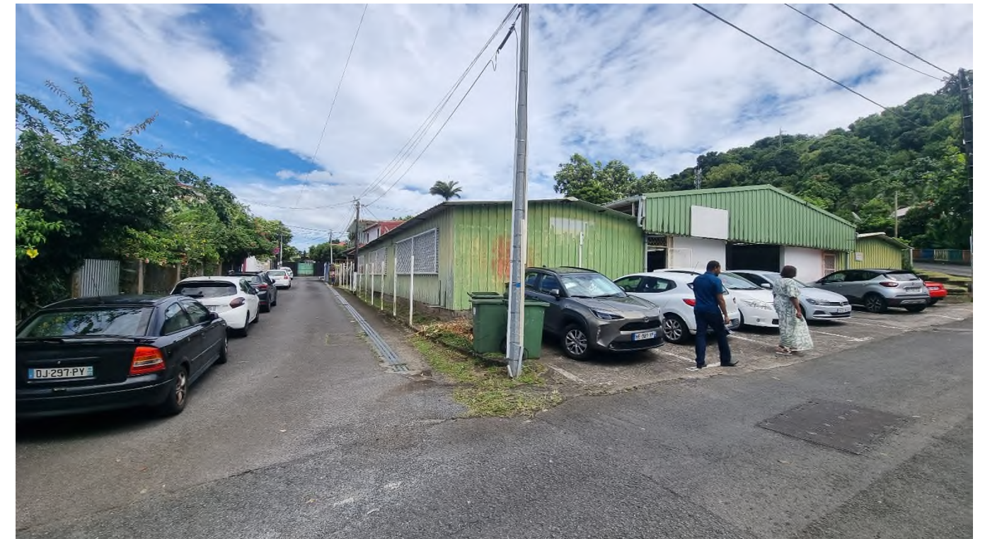
Figure 38 : rue Champfleury et ancienne école à démolir pour créer du parking
