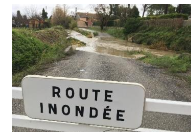
Sécurisation passage à gué
