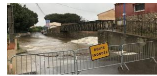
Sécurisation passage à gué
