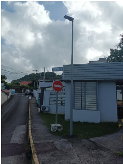
Figure 30 : Candélabre existant (proximité poste de Police)
