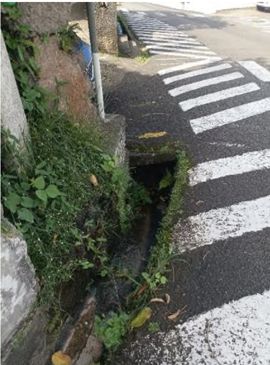
Figure 29 : Busage entre deux caniveaux
