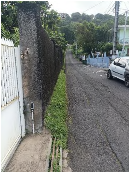
Figure 28 : Caniveau obstrué
