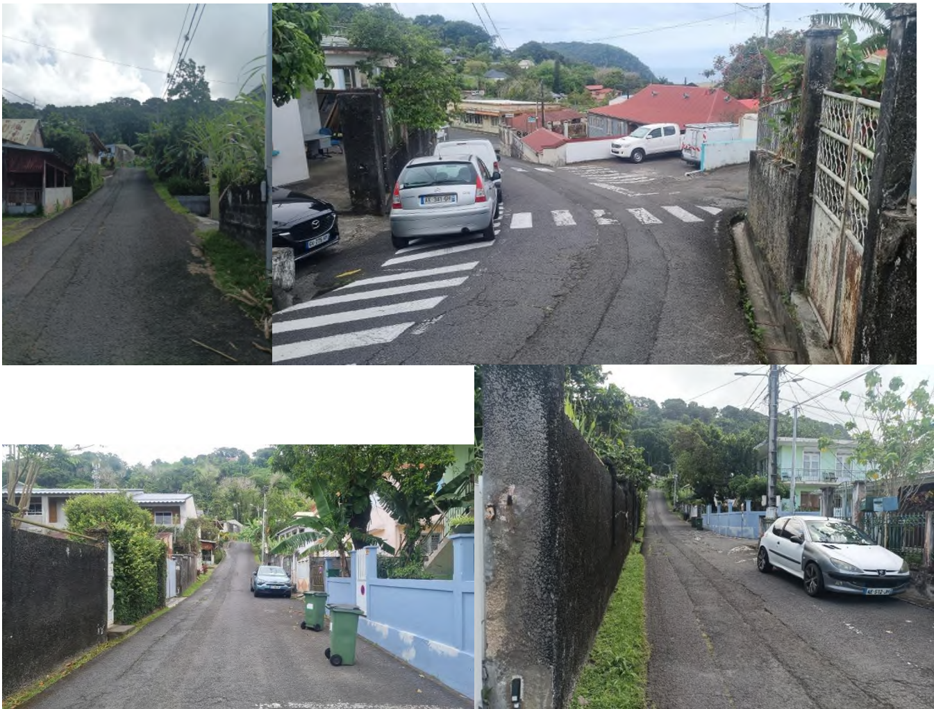
Figure 15 : Photographies de la rue Foccart sans trottoir
