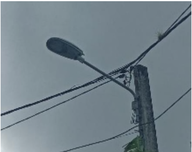
Figure 33 : Luminaire existant ancienne génération sur support commun
