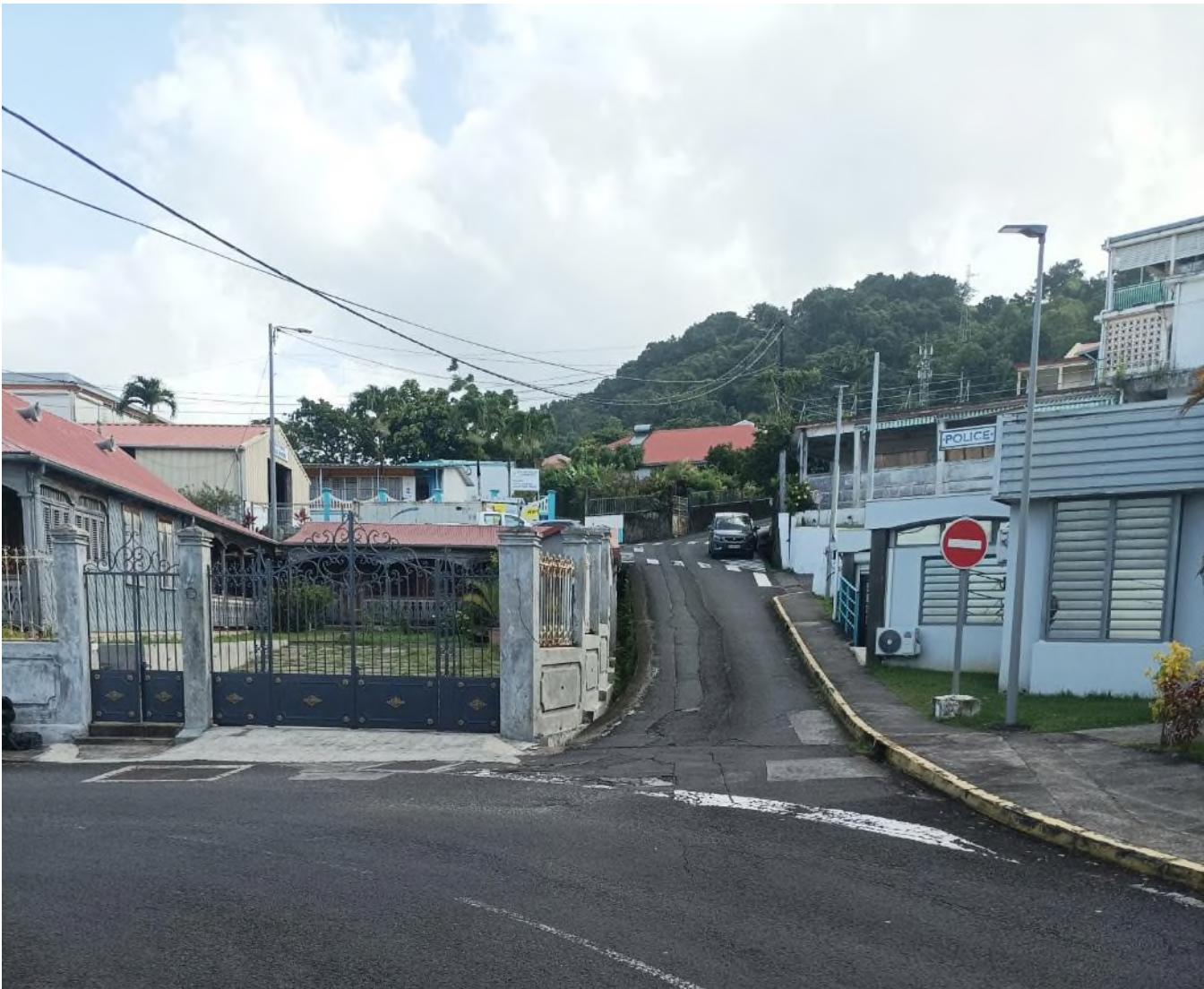
Figure 14 : Photographie du trottoir existant
