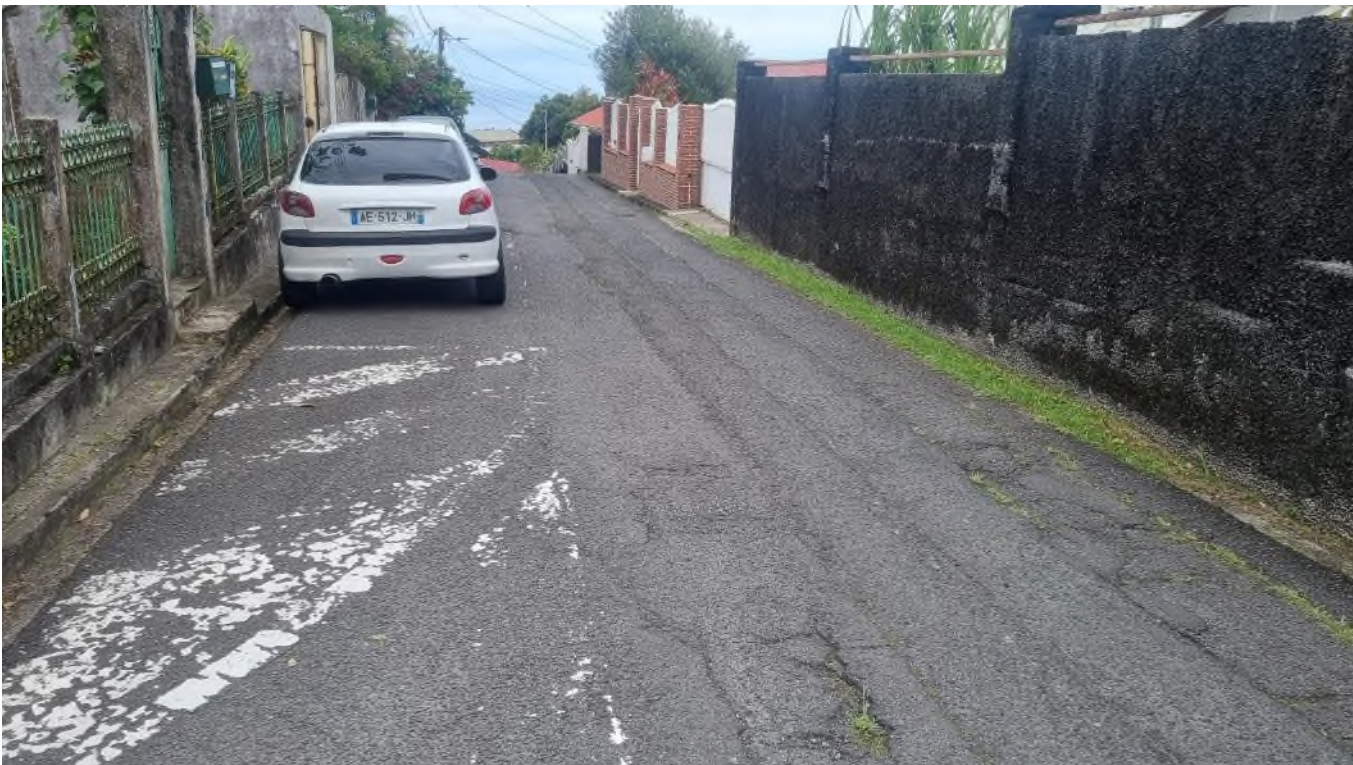
Figure 11 : Fissures observées dans les joints de reprise le long des tranchées + début d'ornières
